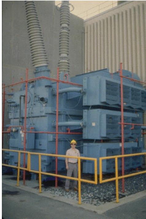
Fonte d'un transformateur causée par l'orage magnétique du 13 mars 1989 sur les installations hydroélectriques québécoises (source : The International Auroral Study, C. Cattel, U. du Minnesota)
